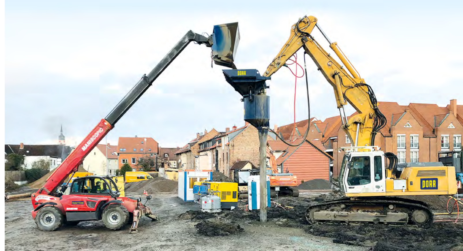
Herstellung von Rüttelstopfsäulen.
