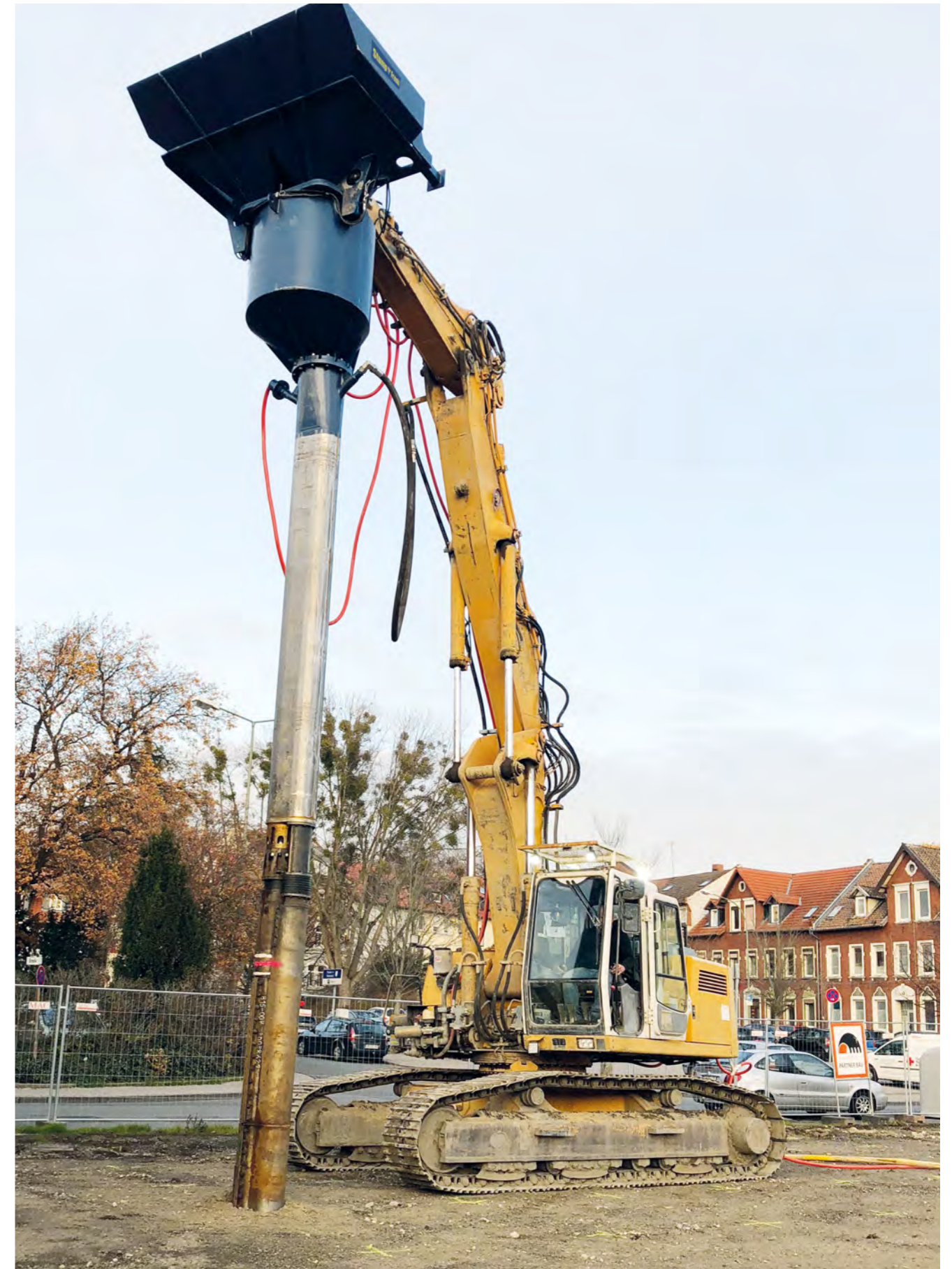
Neubau eines Wohn- und Geschäftskomplexes in Helmstedt, 341 Rüttelstopfsäulen
