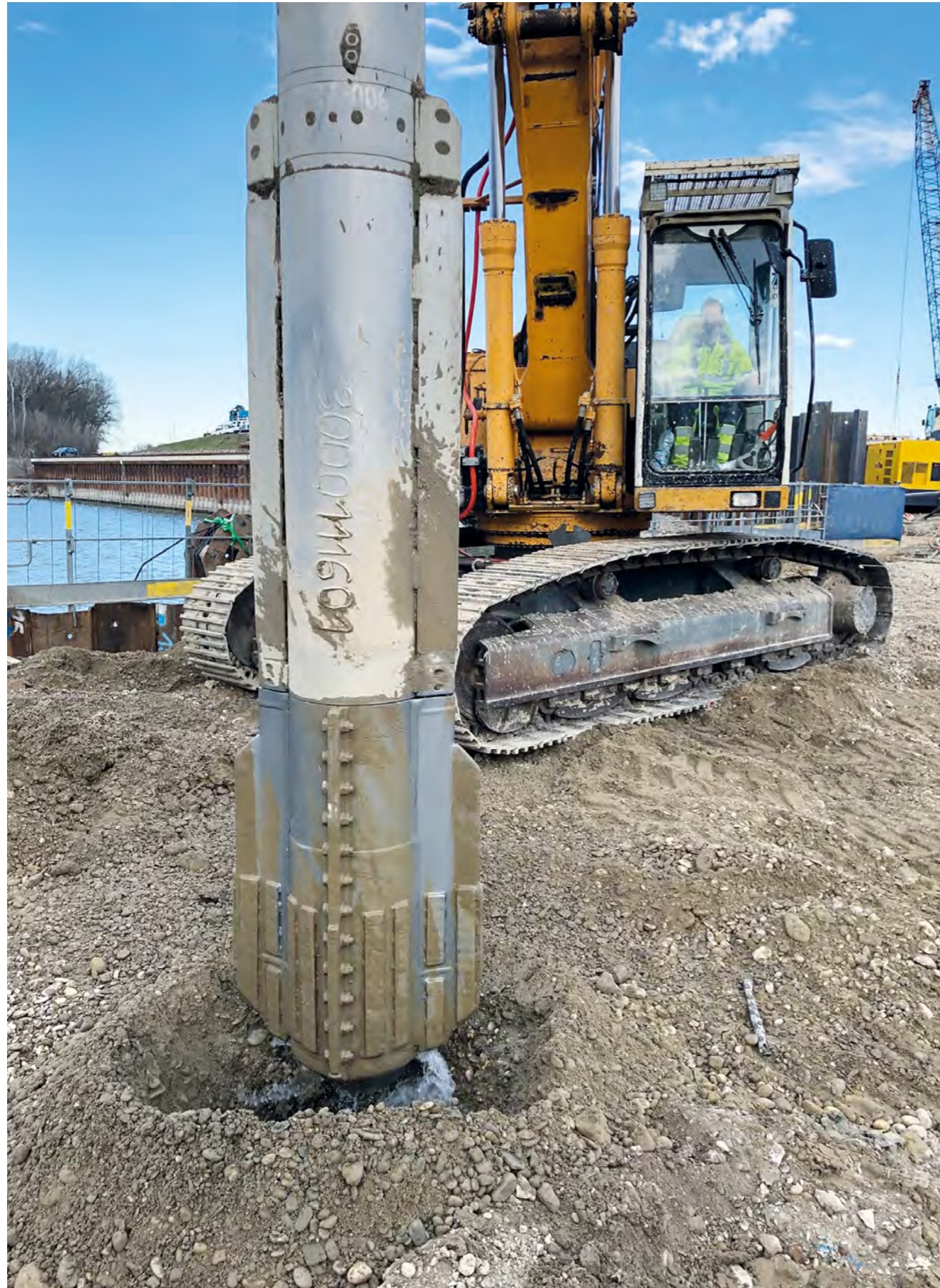
Durch den Rüttler wird der Baugrund seitlich verdrängt und damit verdichtet.
