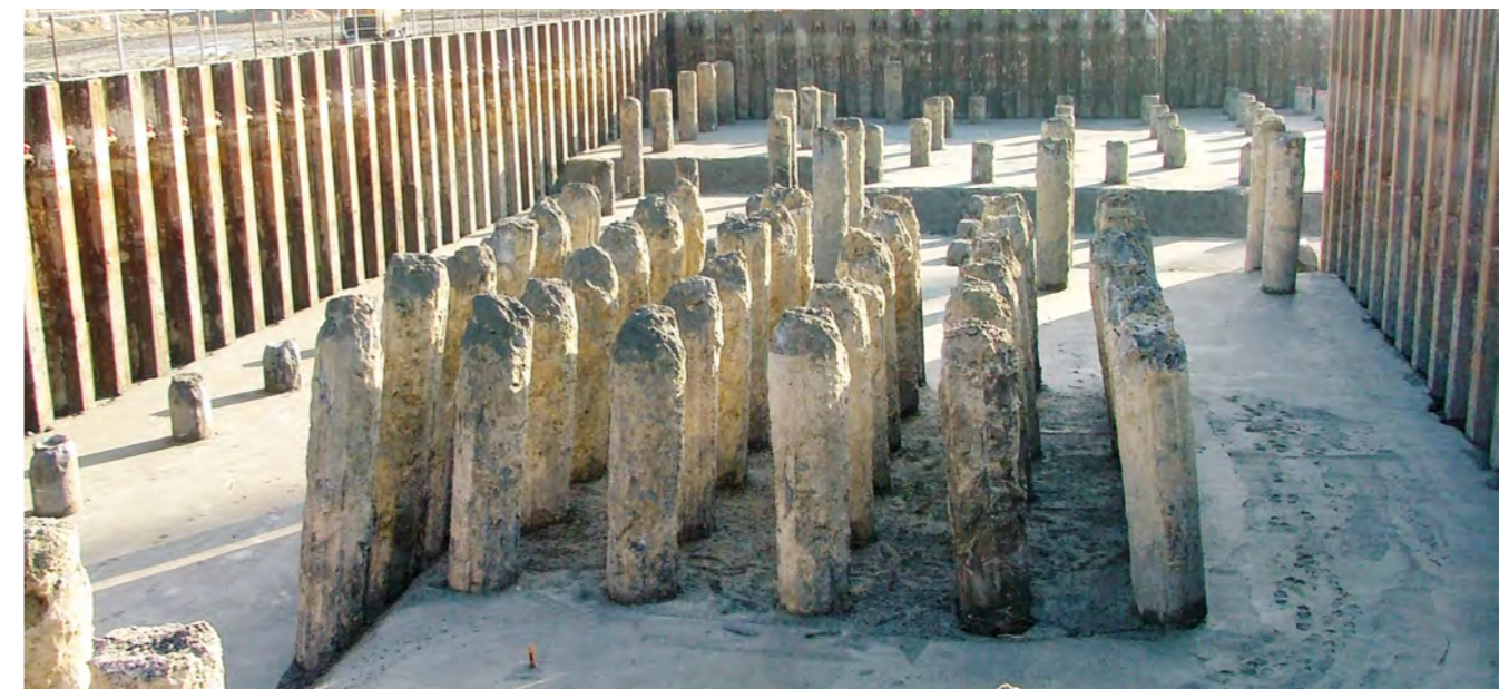
Freigelegte Pfahlköpfe in einer Spundwandbaugrube.
