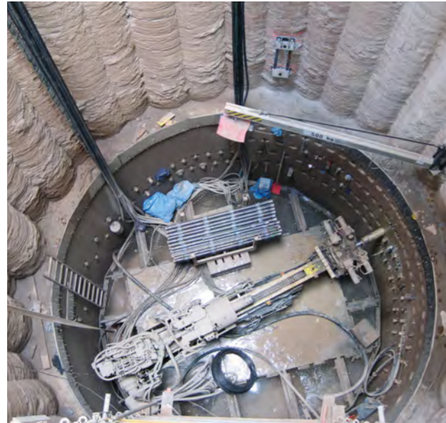
Horizontalbohrungen aus einem Schacht heraus.
