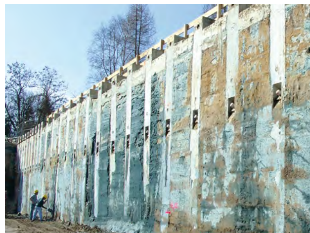
Dichtwand mit eingestellter Spundwand oder Fertigteilen
