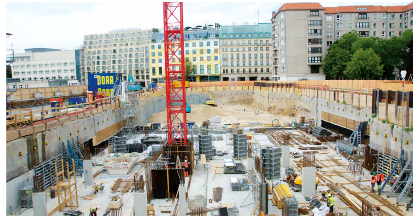
Schlitzwand, verankert, mit Steckträgerverbau
