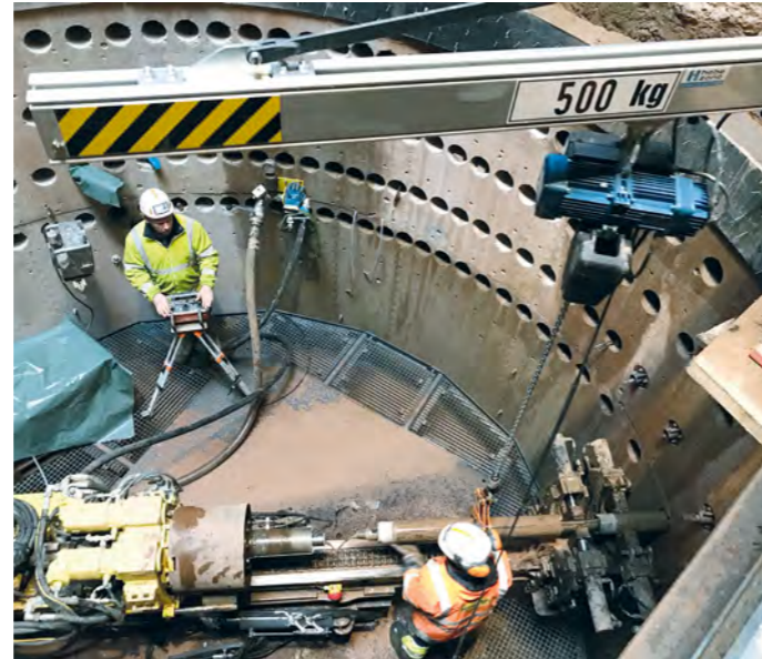
Die Bohrungen werden in einem definierten Abstand aufgefächert ausgeführt.
