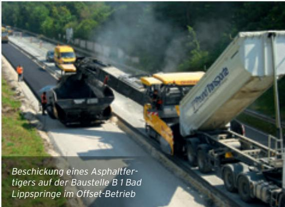
Beschickung eines Asphaltfertigers auf der Baustelle B 1 Bad Lippspringe im Offset-Betrieb
