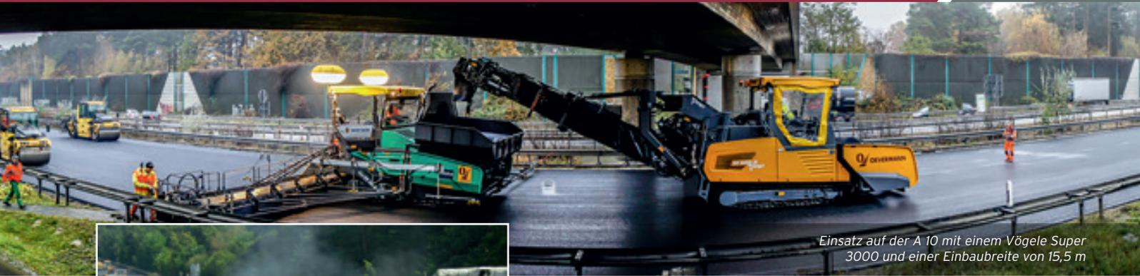
Einsatz auf der A 10 mit einem Vögele Super 3000 und einer Einbaubreite von 15,5 m
