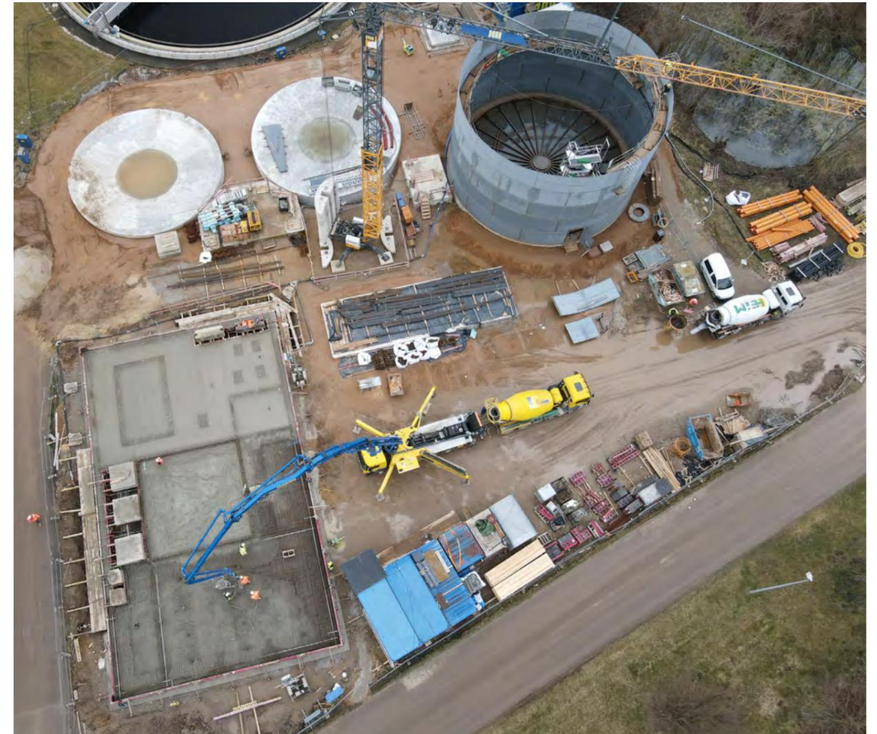
Die bestehende Kläranlage wurde um ein Grobrechengebäude mit Schneckenpumpwerk, ein Vorklärbecken, 2 Faultürme, eine Gasaufbereitung samt 12 m hohem Klärgasspeicher mit 18 m Durchmesser, 12 m Höhe und 2.400 m<sup>3</sup> Füllvolumen, sowie ein Maschinenhaus erweitert. Es wurde als Stahlbetonkonstruktion errichtet und bietet Platz für die Pumpentechnik, neue Zentrifugen für eine effizientere Schlammentwässerung sowie 3 Blockheizkraftwerke.
