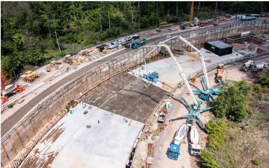
Auch der eingesetzte Beton muss ganz spezielle Eigenschaften aufweisen. Eine eigens entwickelte Rezeptur war notwendig, um die Rohdichte von  $2,35 \text{ kg/dm}^3$  mit einem Restwassergehalt von 4,5 % zu erreichen. Die Herstellung, der Transport und die Verarbeitung stellen dabei sehr hohe Anforderungen an Mensch und Maschine.
